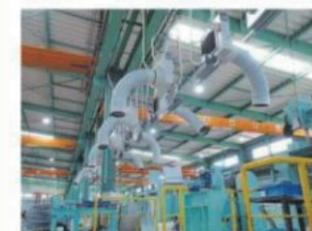
対象エリアを限定して冷風感を供給する空調に有効(冷房時)
