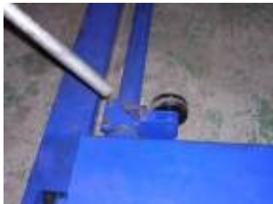
パイプハンドル取付(差込み)
