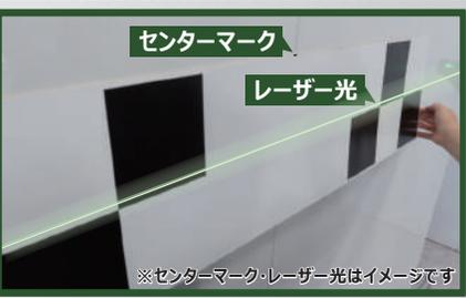
**STEP 6** ターゲットレーザースイッチをオンにする。パネルのセンターラインとガイドレーザーを基準にターゲットを貼りつける。
