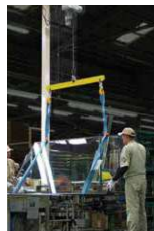
大型窓ガラスの反転作業
